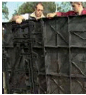
Zusammenbauen der Wandelemente
