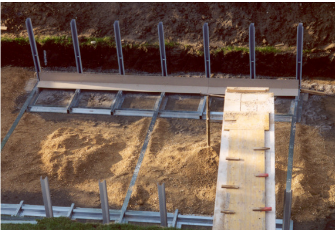
Humus ausstechen (ca. 30 cm) und erstellen des Aushubes
