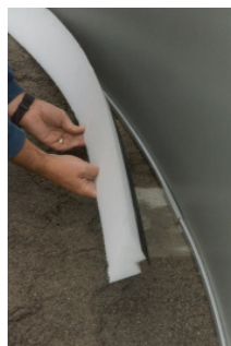
Montieren der Keilprofile
