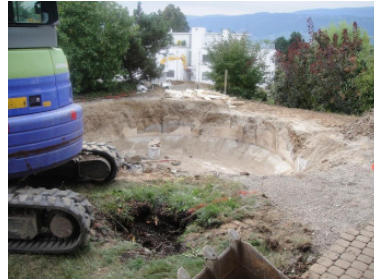
Becken wird angezeichnet und anschliessend wird der Aushub gemacht
