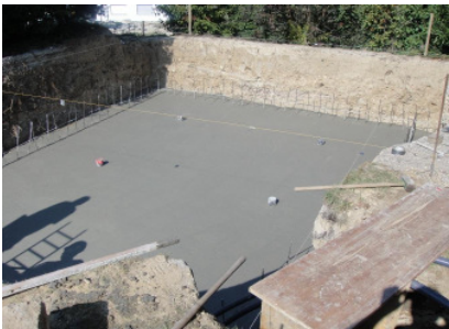
Der Boden wird mit Beton aufgefüllt und im Blei abgezogen
