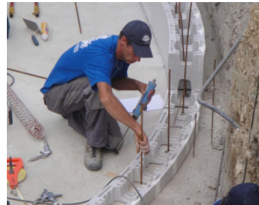
Die Steine werden nun verlegt und mit Armierungen verstrebt
