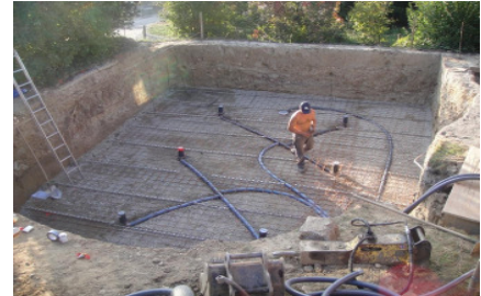
Die Leitungen und die Armierungseisen werden eingebaut und die Bodenplatte verlegt
