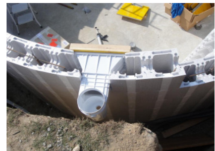
Die Einbauteile werden eingebaut
