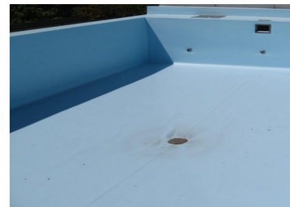
Die Folie wird vor Ort geschweisst
