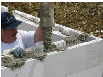
Die Steine werden mit Beton gefüllt
